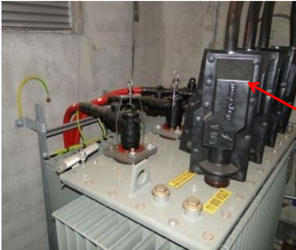
capots isolants (en alternative via des gaines thermo rétractables) pour obtenir un degré IPXX-B
